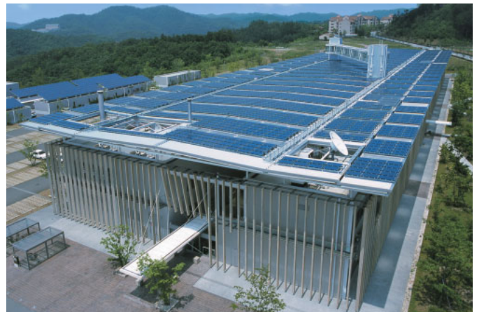
兵庫県西播磨総合庁舎太陽光発電システム
